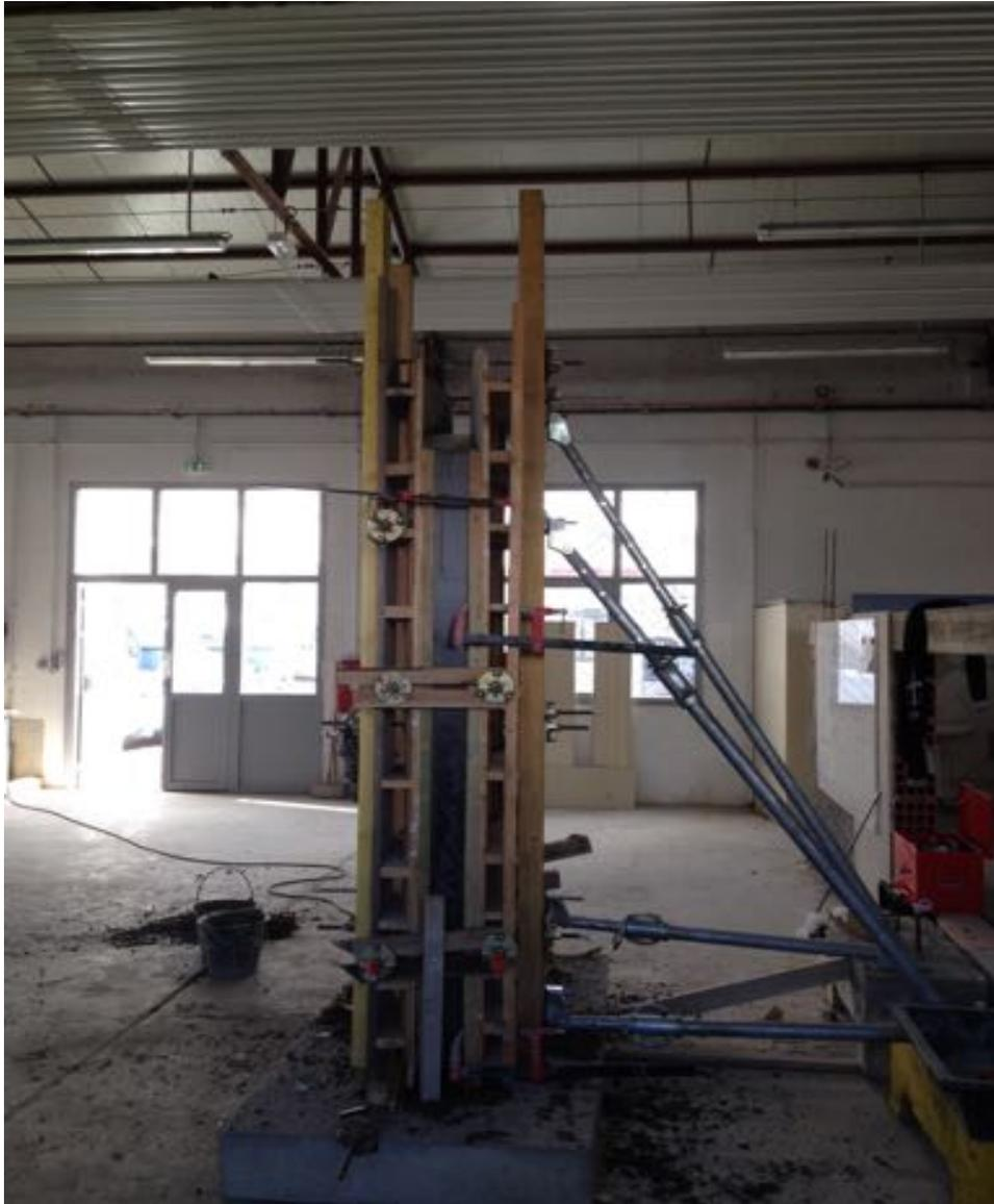
Les tiges filetées qui tiennent les deux voiles courbes n'ont pas été disposées de n'importe quelle façon, on les a positionnées en fonction de la poussée du béton. La poussée du béton est plus importante vers le bas. Il fallait aussi que les tiges filetées puissent passer entre l'armature ainsi qu'entre les lettres.
