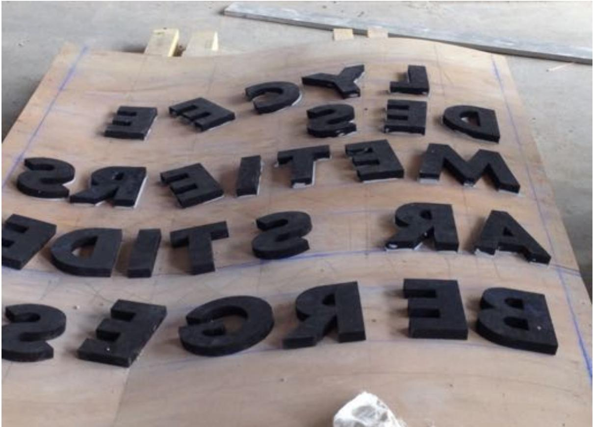
Les lettres doivent être collées à l'envers sur le coffrage pour apparaître à l'endroit sur le béton une fois décoffré. On a tracé les espacements de même mesure entre chaque rangée de lettres. Toutes les lettres sont alignées verticalement sauf les lettres E qui ont été fixées de biais. Les lettres ont été collées avec du mastic colle polyuréthane Sika 11FC.
