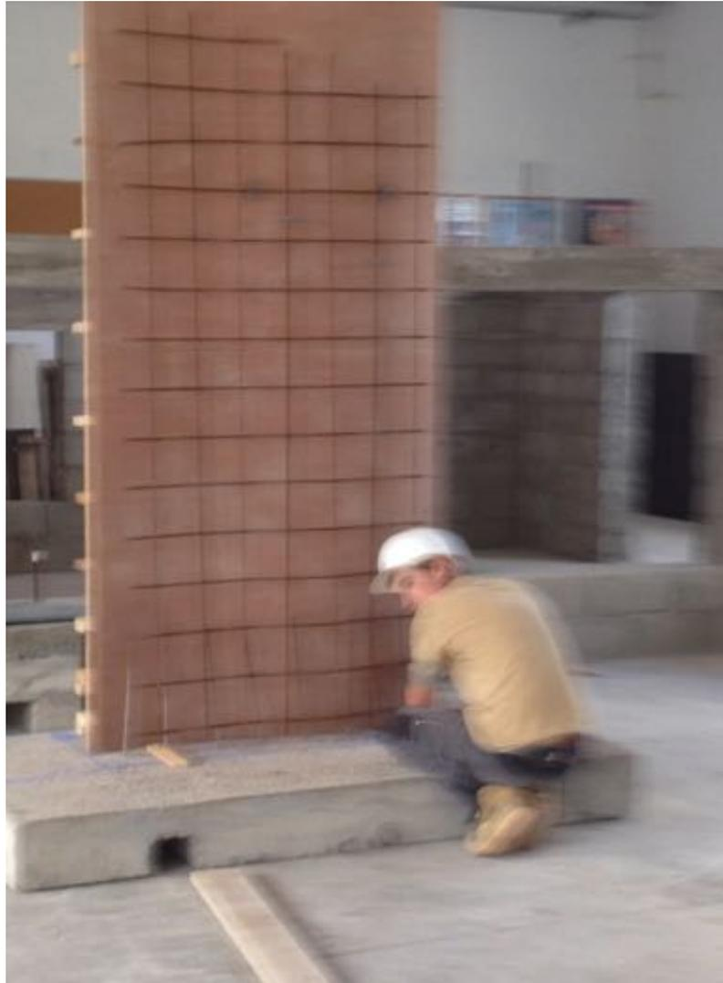
L'armature a été découpée dans une plaque de treillis soudés H.A.6, puis nous avons rajouté des renforts horizontaux et verticaux en H.A.8. L'ensemble de cette armature a été raccordé aux attentes de la dalle en H.A.8.
