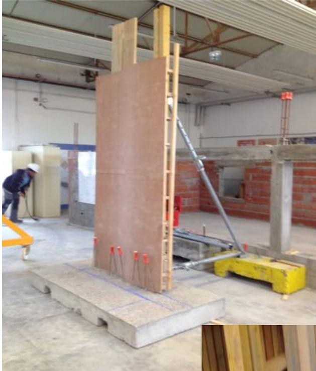
L'emplacement du coffrage a été tracé sur la dalle au cordex.
